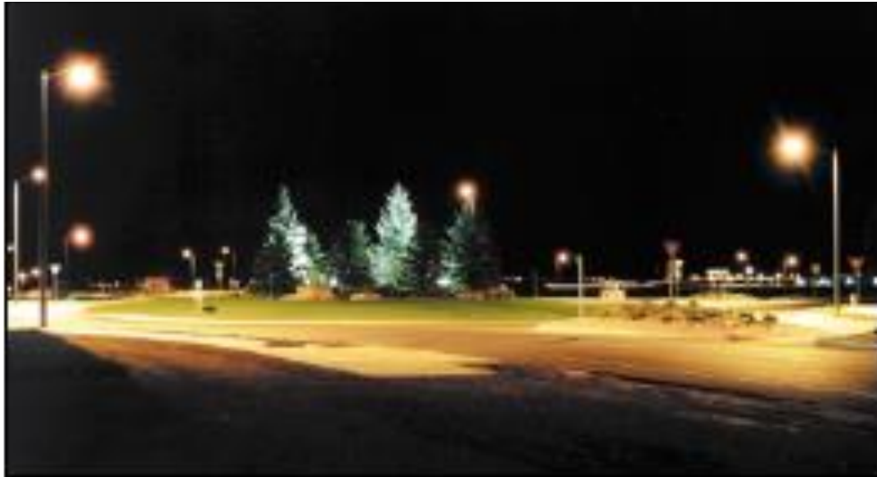
Fotografía 8. Iluminación de rotonda (Fuente: Roundabouts)
