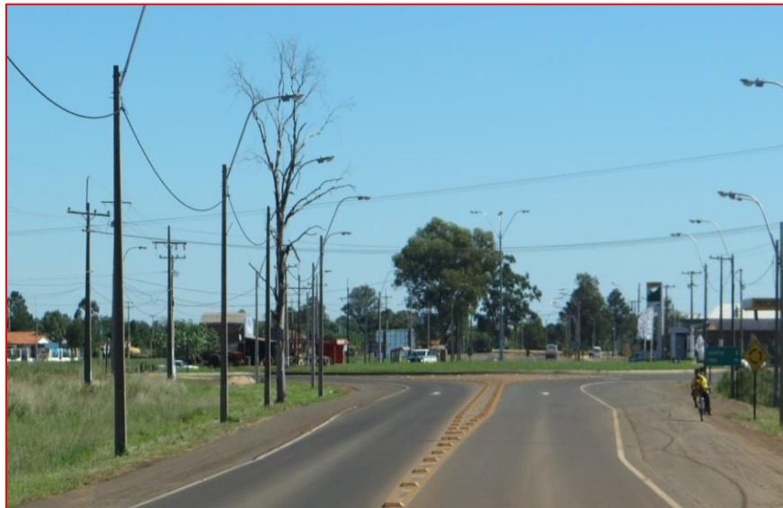
Figura 7. Falta de señalización y gran cantidad de columnas en el acceso a la rotonda.
