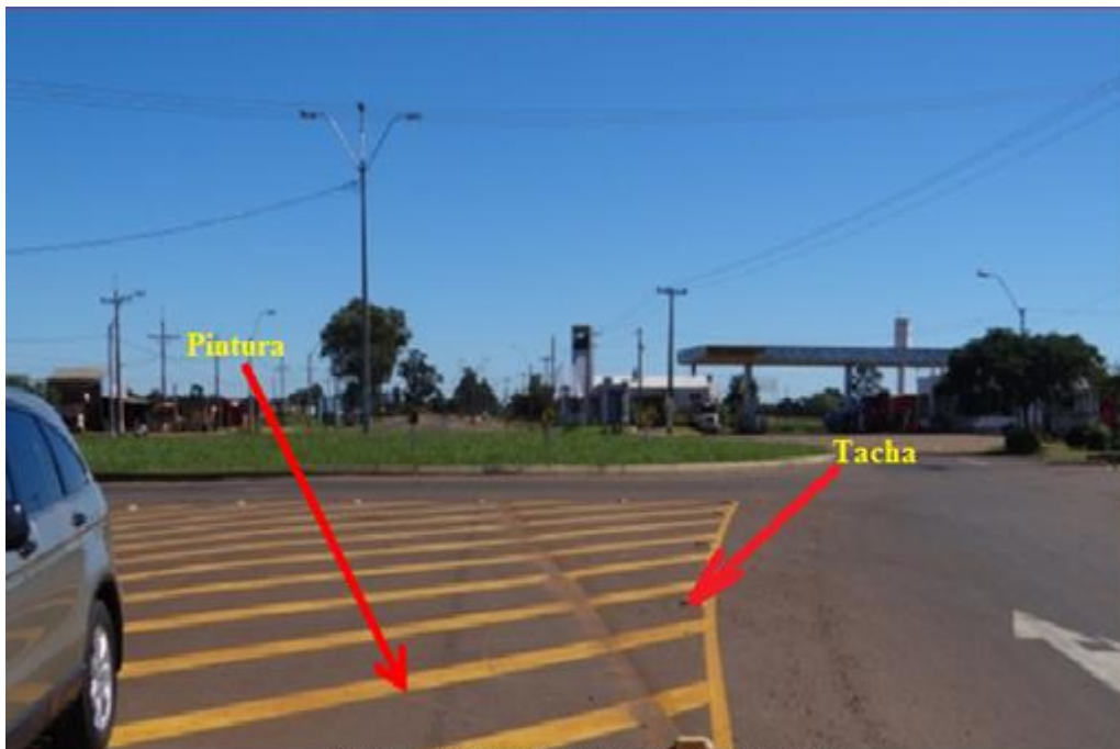
Figura 5. Isleta deflectoras demarcada en el pavimento
